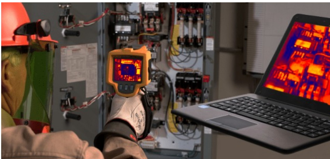
Рисунок 20. Пример проведения тепловизионного контроля электрошкафа
